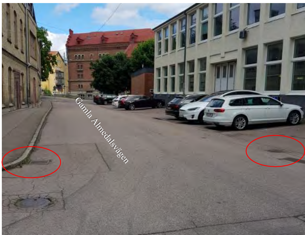
Figur 14 Bild på befintligt dagvattensystem på Gamla Almedalsvägen. Dagvattenbrunnar är markerade med röda cirklar (Ramboll 2020).
